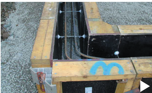
Armeringen legges oppå formstagene og bindes fast. Stor nøyaktighet og ekstrem styrke blir resultatet.
