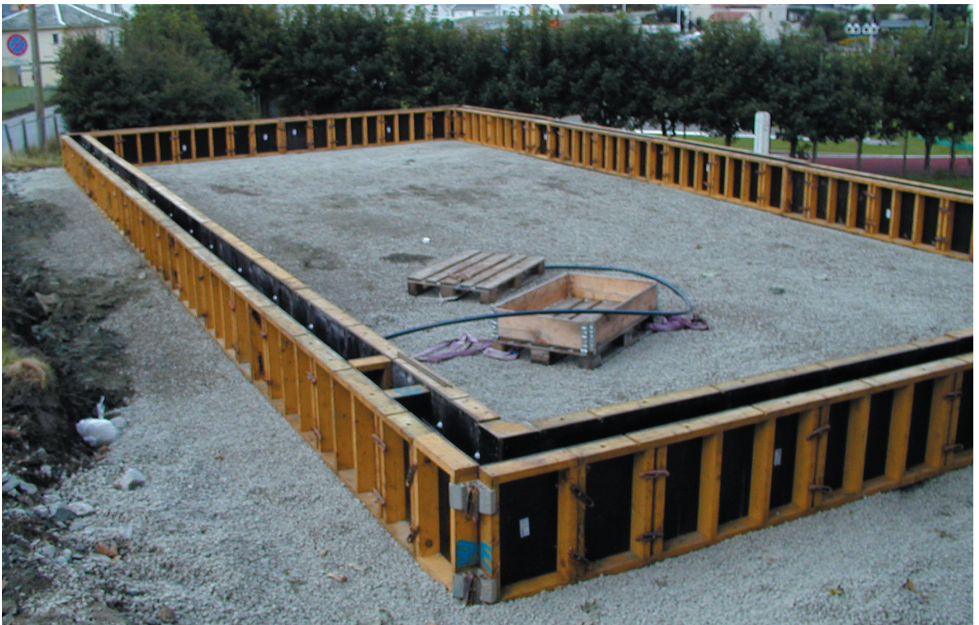
Malthus ringmurforskaling klar for støping!
