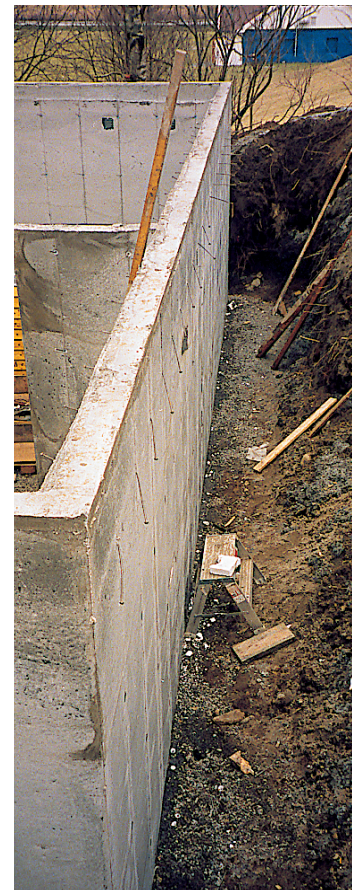
Ferdig mur med kjerneisolering.
